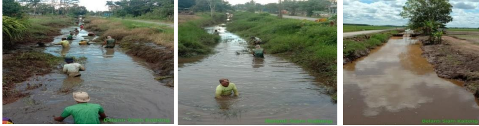
Gambar 104. Pembersihan saluran tersier
