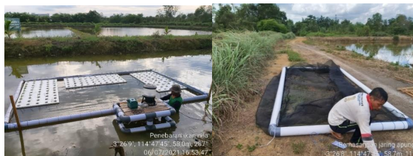
Gambar 48. Pemasangan rangka paralon, styrofoam, net pot, dan jaring apung
