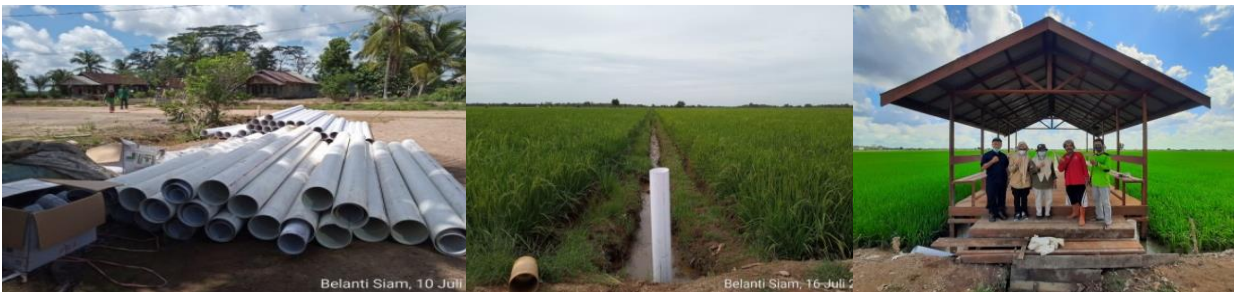
Gambar 105. Perbaikan pintu-pintu saluran dan pembenahan prasarana lainnya
