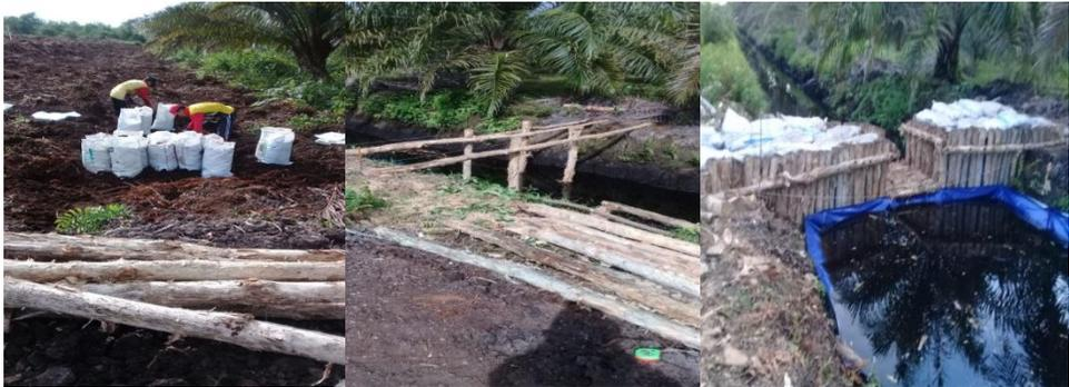
Gambar 14. Kegiatan penelitian komponen teknologi pengelolaan air sampai pada pembuatan tabat di Saluran sekunder
